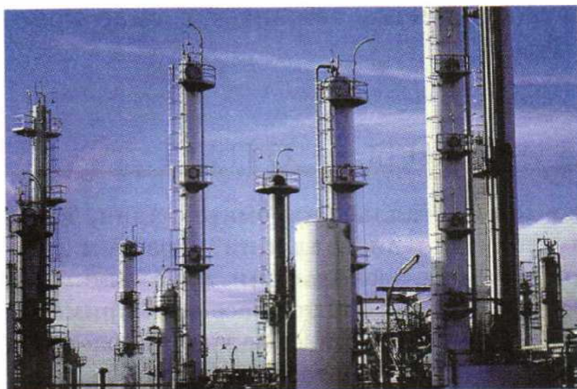
Рис. 89. Ректификационные колонны нефтеперерабатывающего завода
